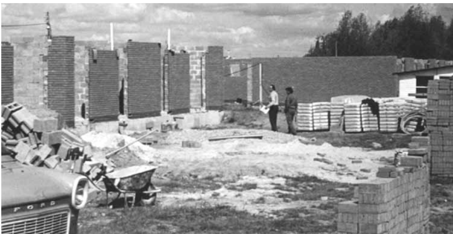
Aanbouw van de Theo Vinckxlaan
